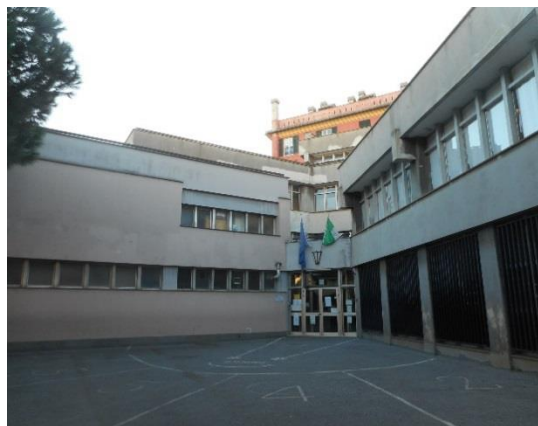
Figura 1.1 - Vista della facciata di ingresso esposta a Nord-Est
