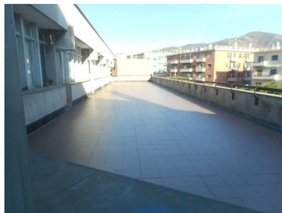
Figura 4.2 - Particolare della copertura
