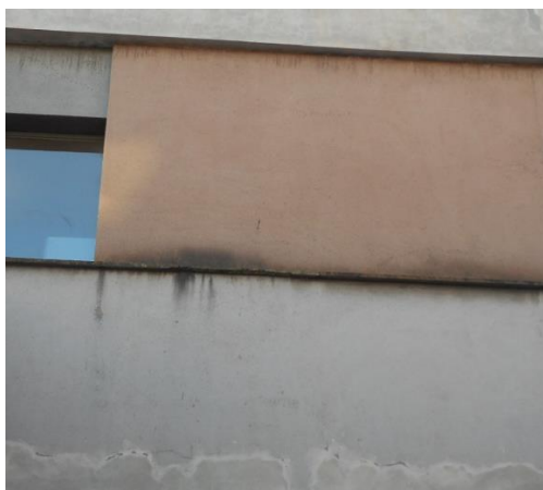
Figura 4.1 - Particolare della porzione di involucro
